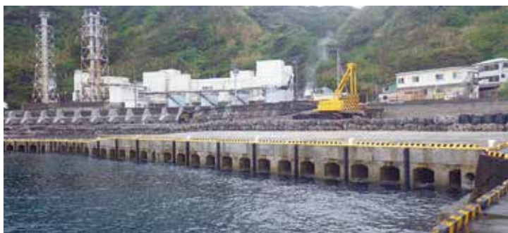
岸壁(-4.5m)建設後
